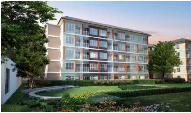
Picture 3 : โครงการ ไมอามี บางปู
